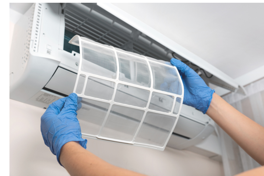
Manutenção de Ar Condicionado
