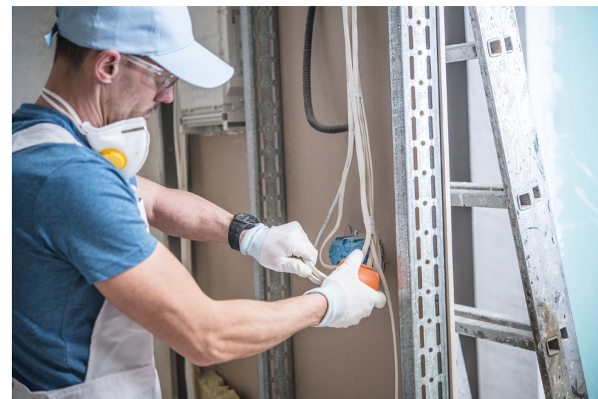
Instalação e Manutenção Elétrica
